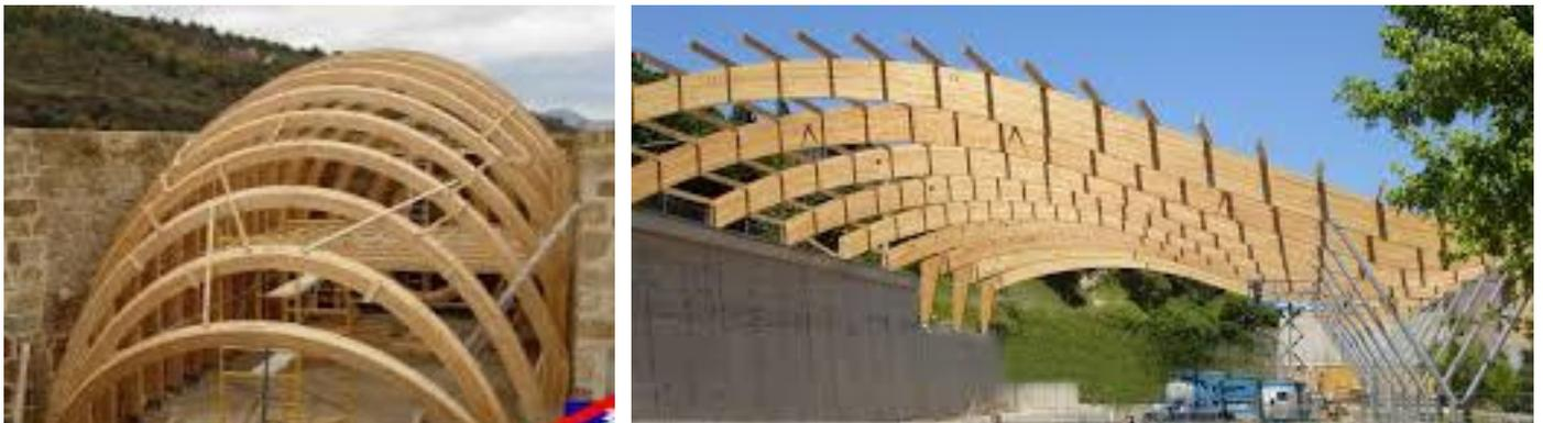
El hecho de que la pieza final se componga de láminas hace que el defecto máximo sea el equivalente al espesor de una lámina. El producto se compone de láminas de madera saneadas: **es por lo tanto más homogéneo que la madera maciza y puede trabajar a tensiones más elevadas.**
