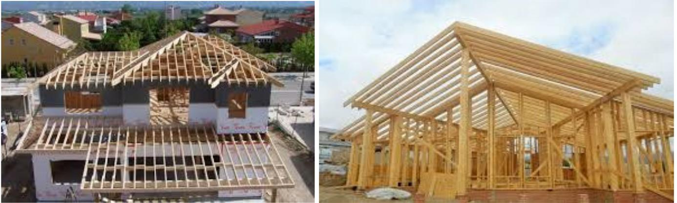
Se pueden realizar bajo cubiertas habitables utilizando cerchas con una geometría que permita la utilización del espacio bajo cubierta. Otra forma de realizar cubiertas habitables es la de colocar un forjado horizontal para ser pisado y otro forjado inclinado como estructuras de cubierta. Es posible la realización de cubiertas, autoportantes por medio de paneles contrachapados unidos a través de nervios de madera. Estos paneles forman una especie de cajón que se rellena de aislamiento.
